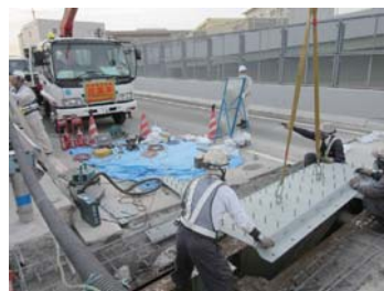
新しい構造の床版連結施工 (土木施工 2014 Jul VOL.56 No.7より)
