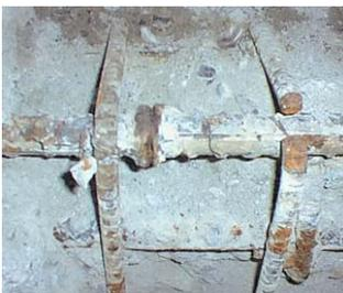
図1 ASRによる鉄筋破断状況
