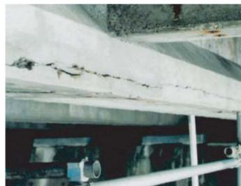
図2 塩害によるひび割れ状況
