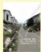
図-3 2016年熊本地震における人工造成地帯の被害状況
