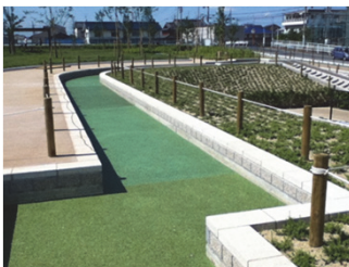
景観樹脂舗装(四條畷市): 藤野興業㈱提供
