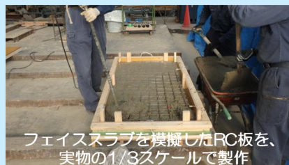
供試体製作状況
