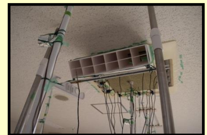
風量測定状況
