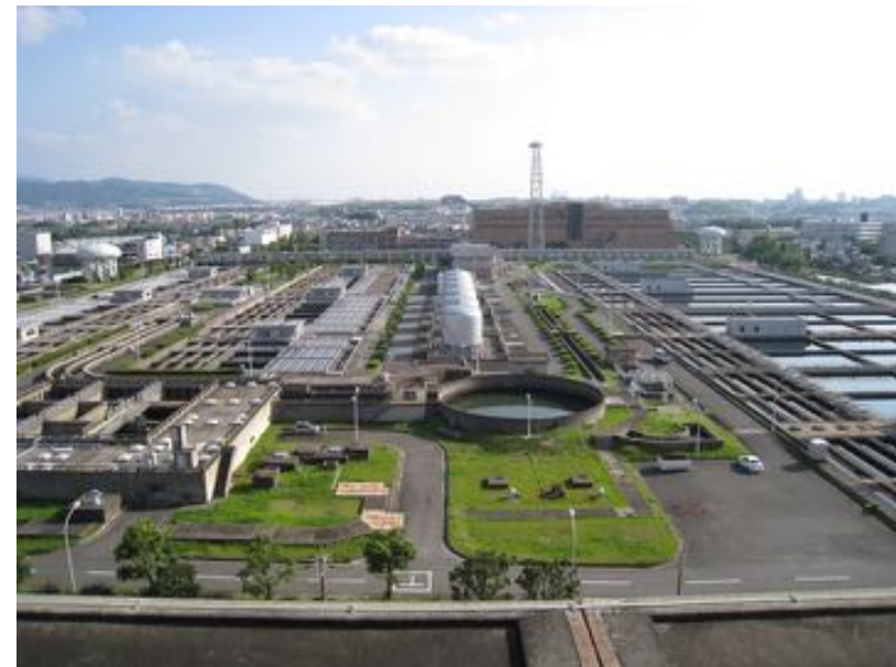
大阪広域水道企業団 村野浄水場
